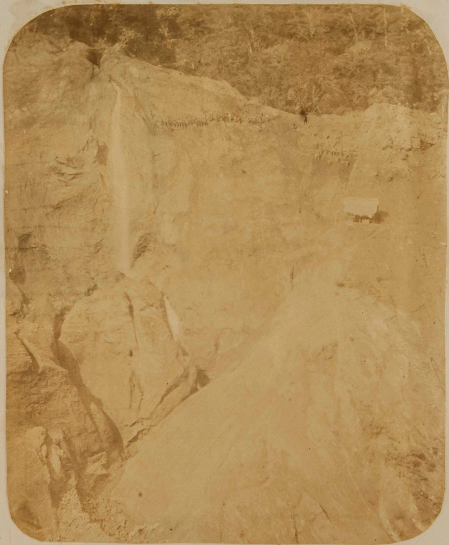
Minas de esmeraldas de Muro Chorro para el lavado de los derrumbes
