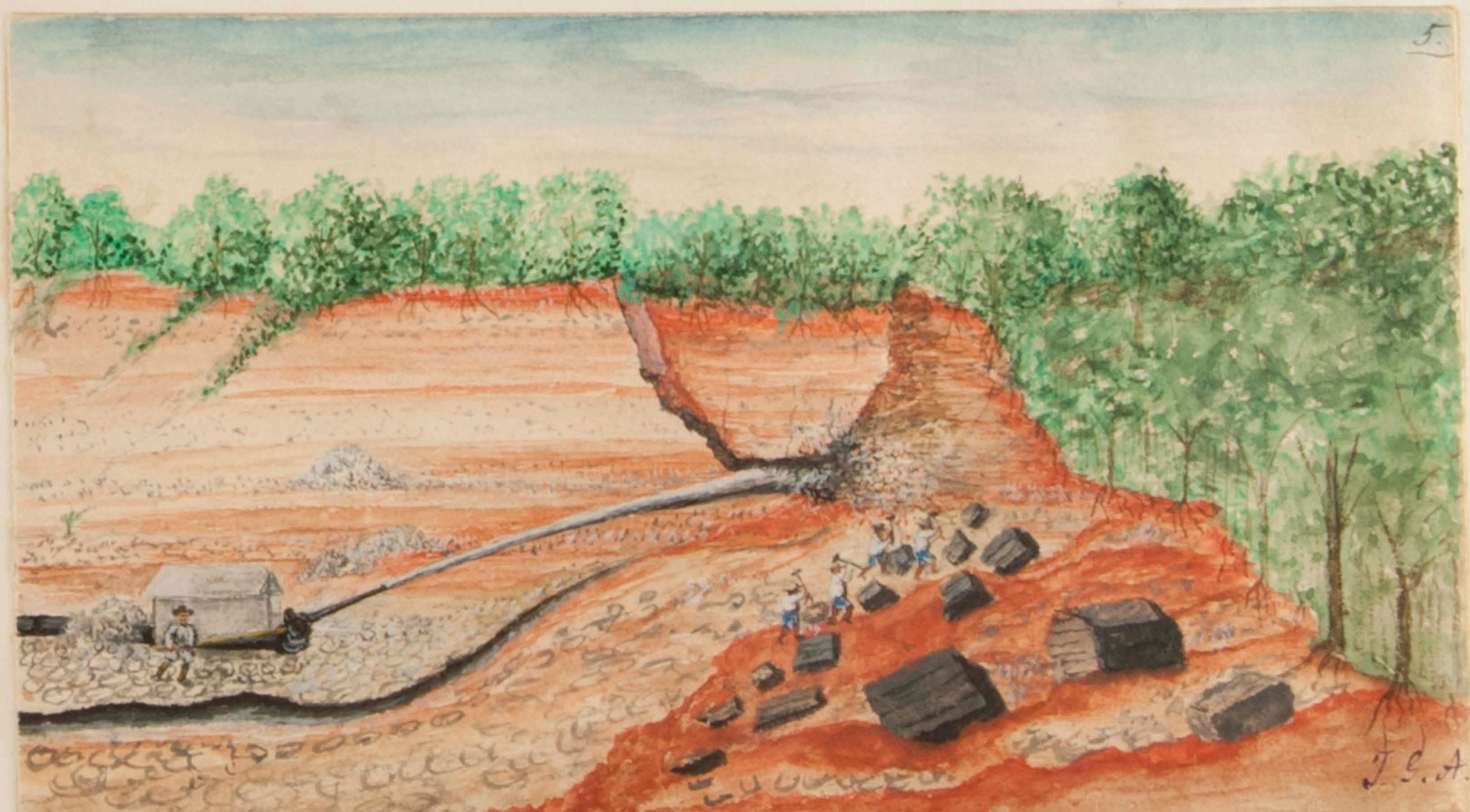
Mina de oro Mat-paso - Derrumbes por la máquina hidráulica. 3 de Junio 74
