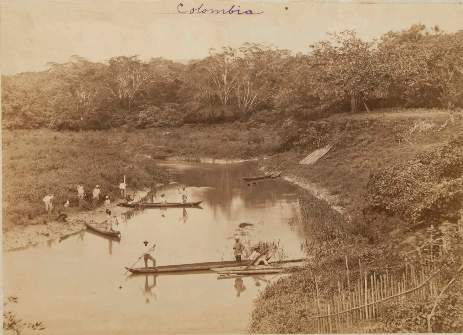
Trabajos del canal de Panamá Estación de Jamboá en el río Chagres.
