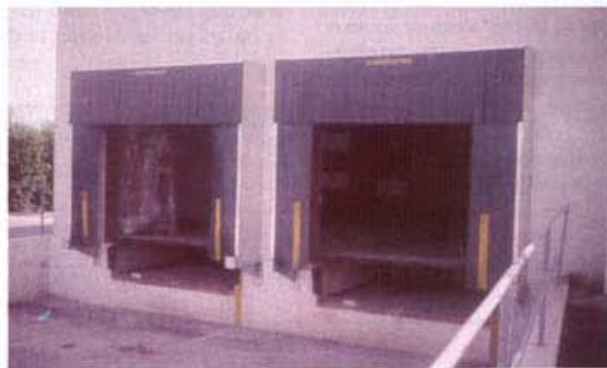
Cámara para el almacenamiento refrigerado
