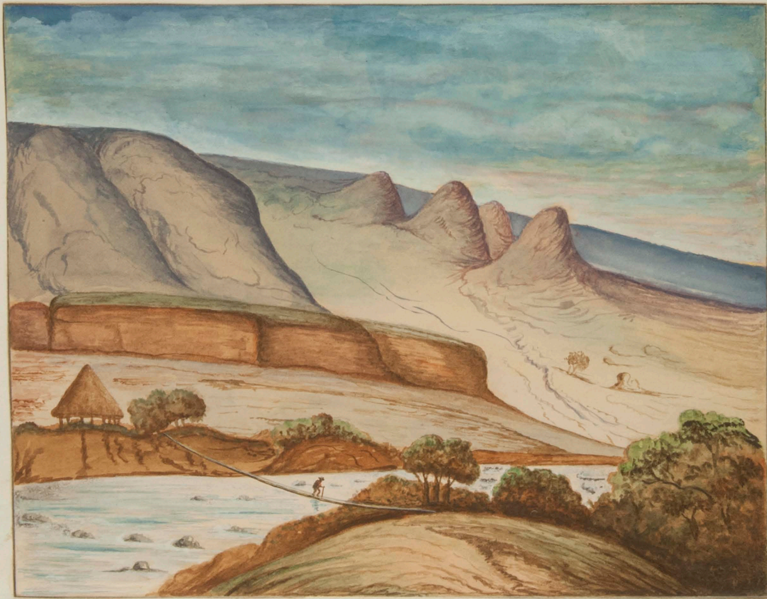
Puente improvisado con un solo tronco sobre el río Juanambú. (E. del Cauca)
