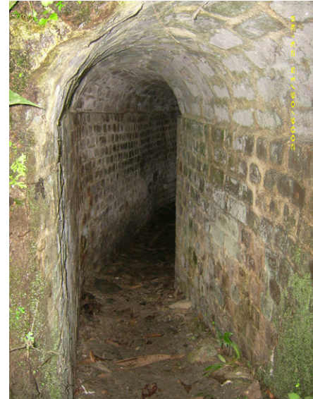
Aún se conservan vestigios de las minas de Santa Ana (Falán) como la de este túnel.
